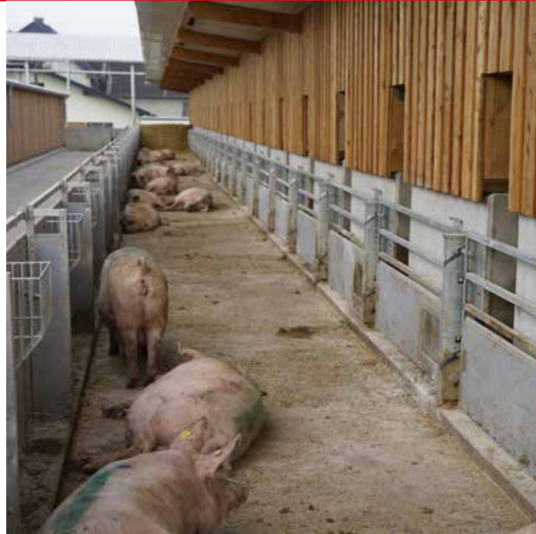
Quick.Gate – Cette porte peut séparer brièvement l'intérieur et l'extérieur de la porcherie
