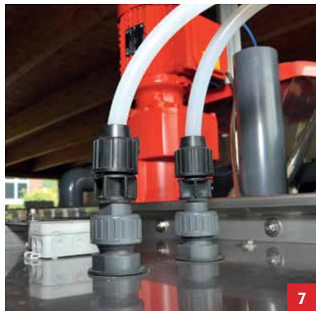
Conexión de limpieza con ácido y desinfectante en el tanque de mezcla
