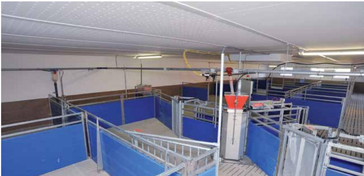
Ventilación por falso techo perforado
