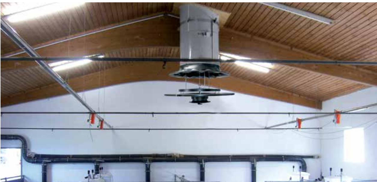
Ventilación con chimenea de entrada de aire.
