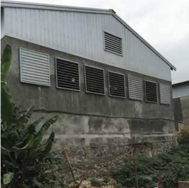
Ventilación tipo túnel combinada
