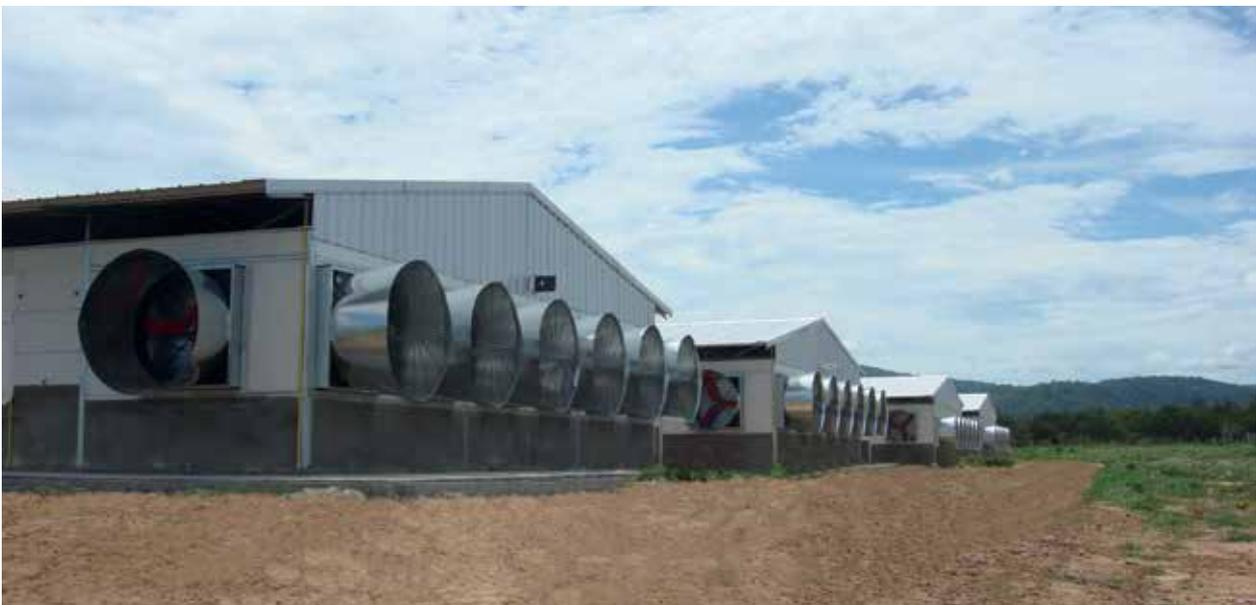
Ventilación tipo túnel (Gran Caudal con Cono)
