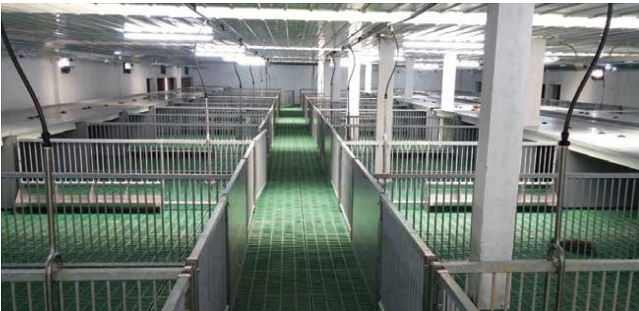
Ventilation combinée tunnel
