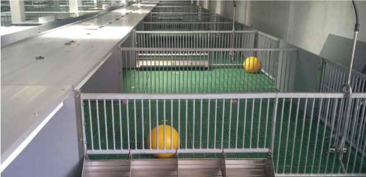
Case de porcelets pour les installations avec ventilation tunnel
