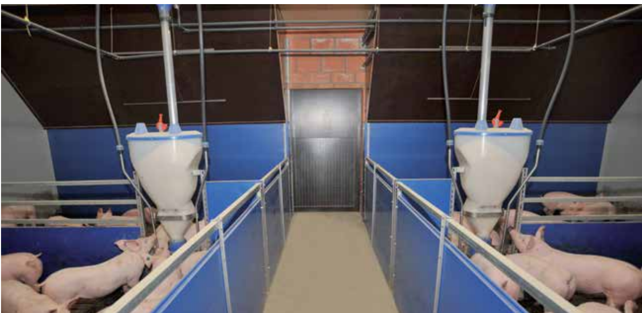
Ventilation Couloir par passage de porte
