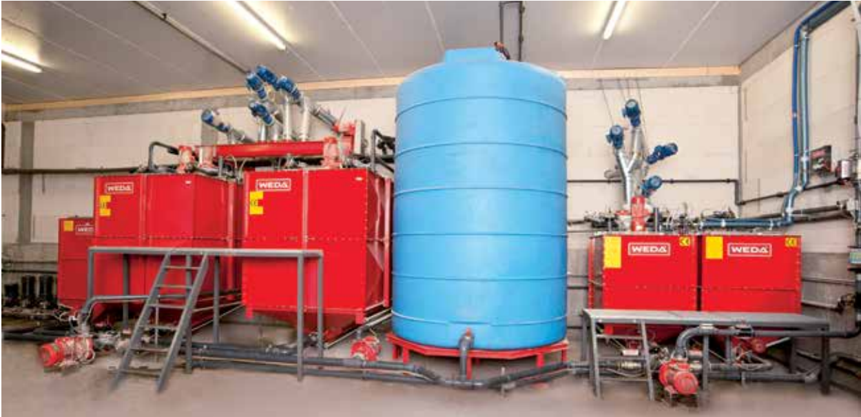
Installation pour 10 000 places d'engraissement et 5 000 porcelets
