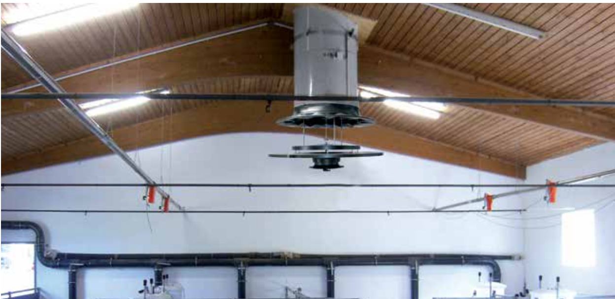
Légbeejtőkürtőn keresztül történő szellőztetés
