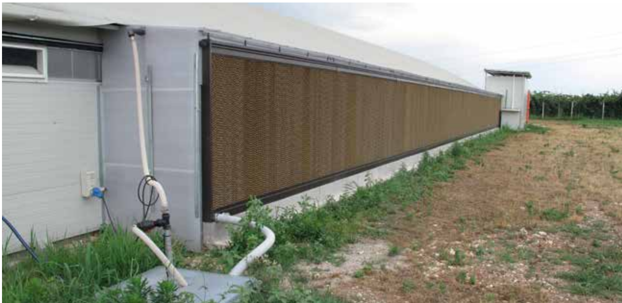
Hűtőpaneles klímarendszer
