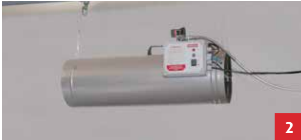
1 Bordázott cső 2 Hőlégbefúvó
