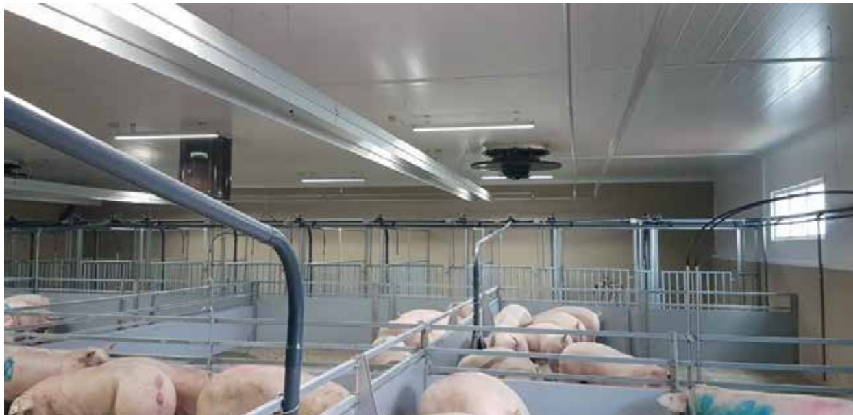
Вентиляция с распределителем приточного воздуха
