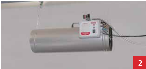
1 Ребристая трубка 2 Газовая воздуходувка
