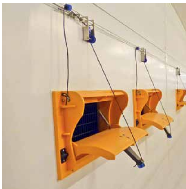
Настенный приточный клапан
