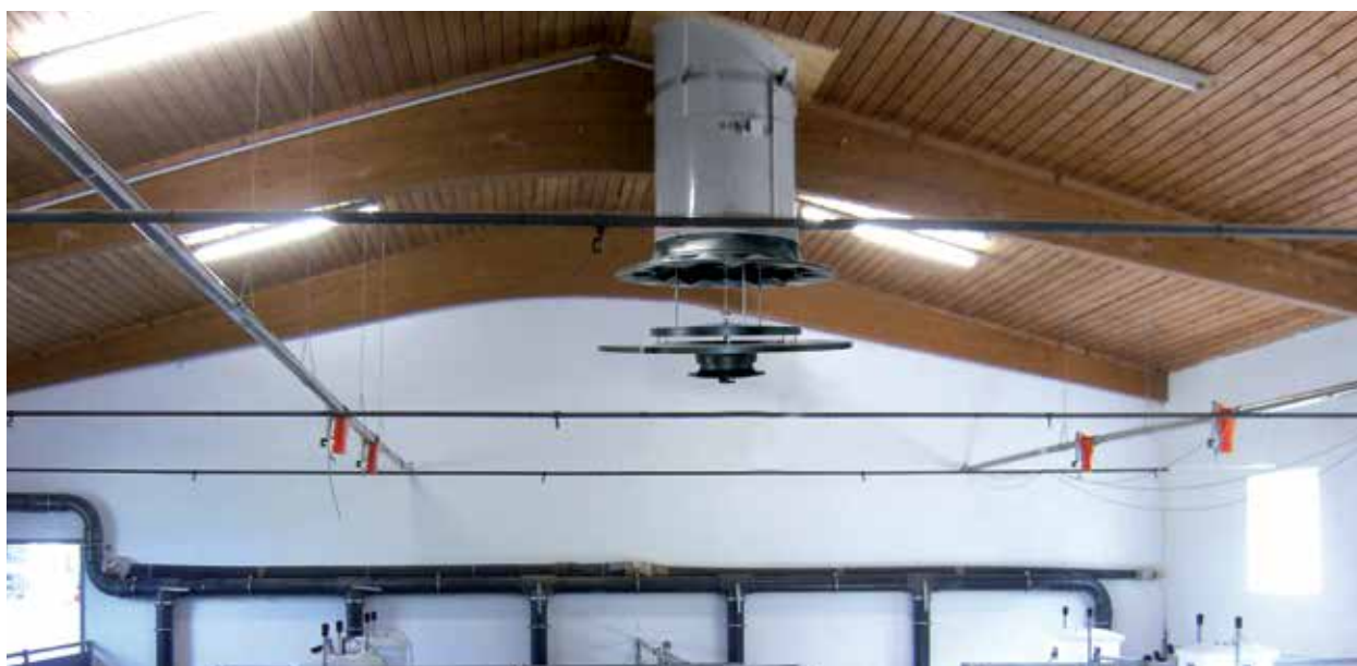
Вентиляция с распределителем приточного воздуха
