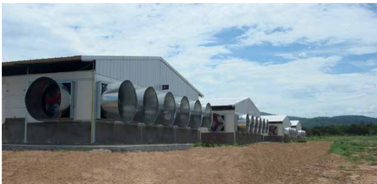
Туннельная вентиляция с конусовидными вентиляторами
