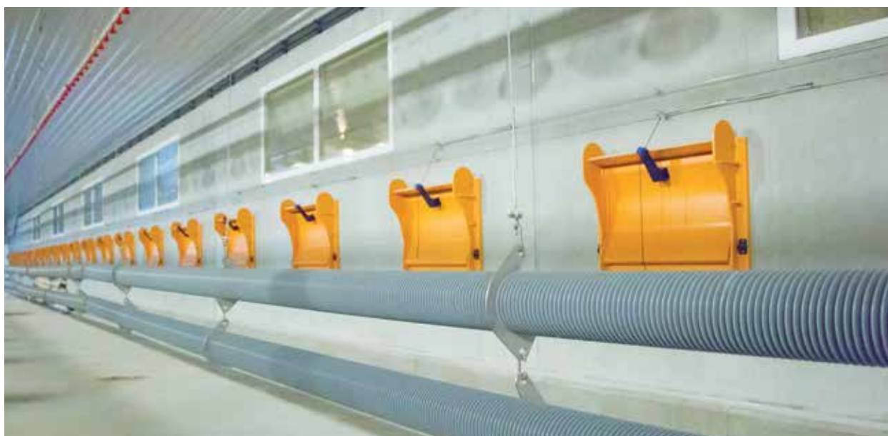
Вентиляция со сосредоточенной подачей воздуха
