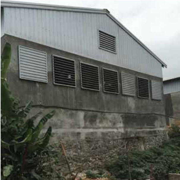
혼합 터널 환기
