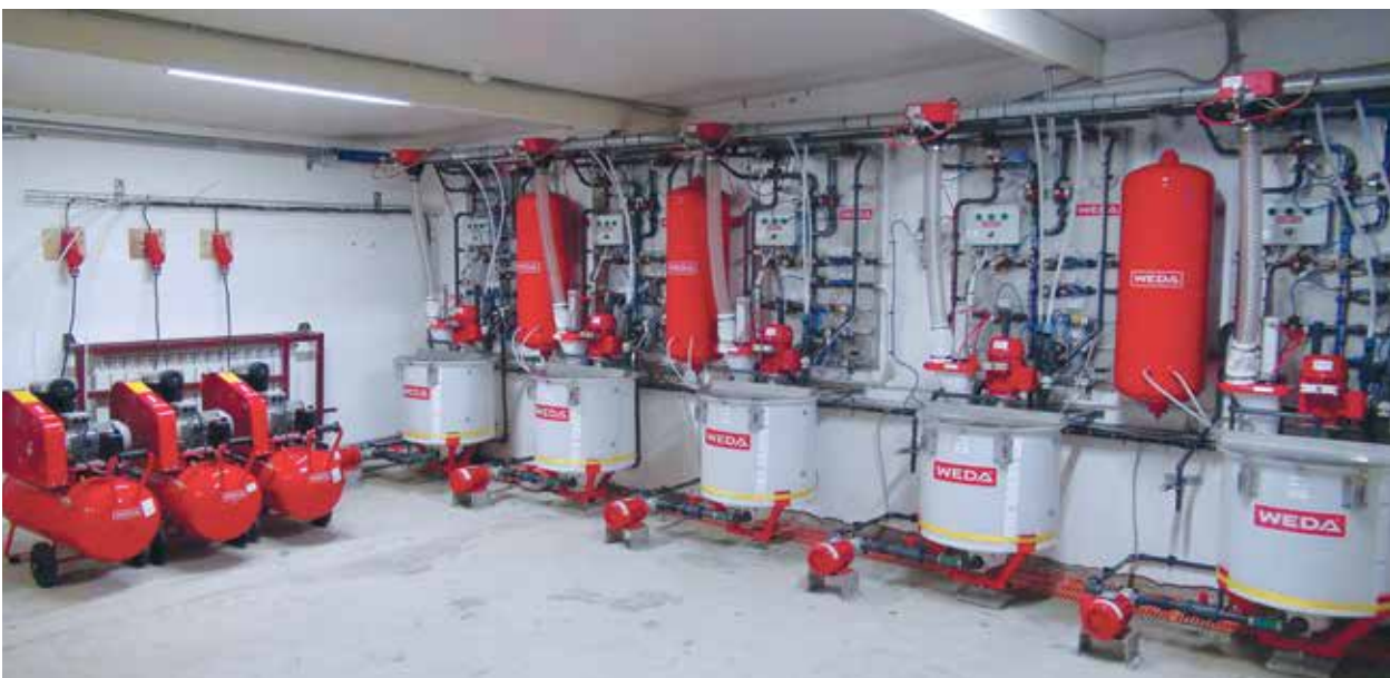
System z 2500 miejscami dla loch w systemie równoległym (system można rozbudować do 4000 miejsc).
