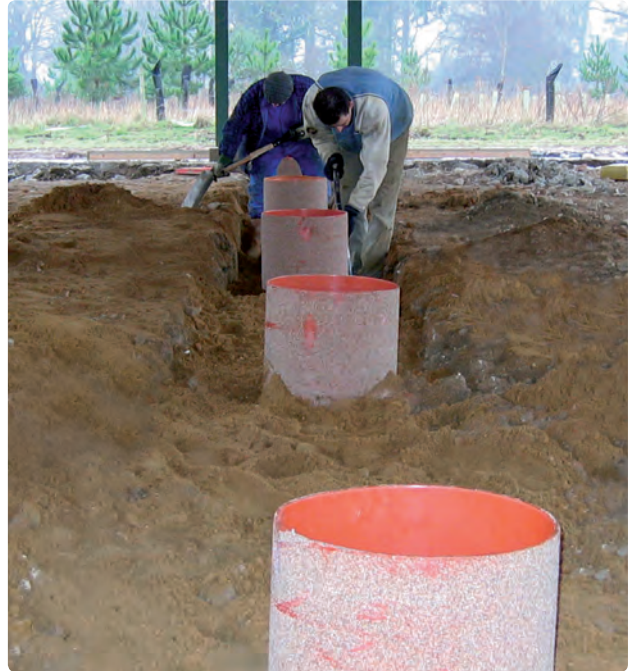
Manuelle Verfüllung und Verdichtung des Erdreiches
