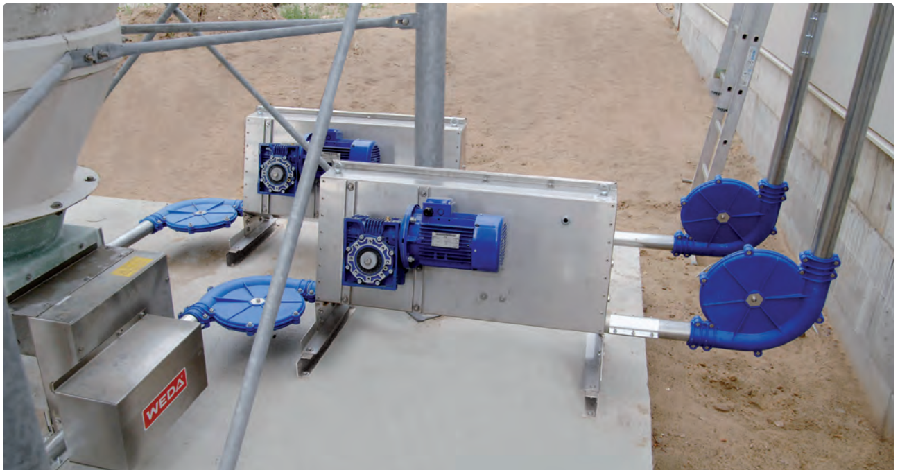
Förderung der Trockenkomponenten außerhalb des Stalles
