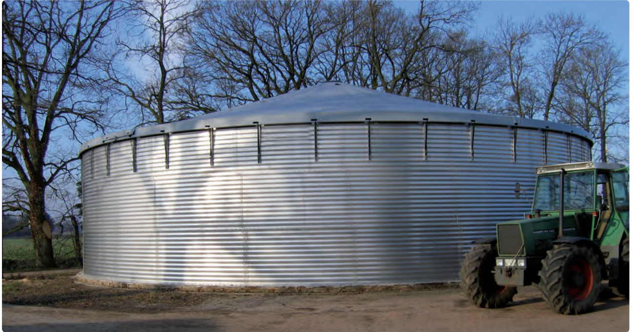
Wellstahlbehälter mit Foliendach
