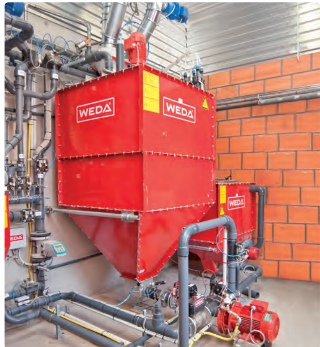
Mit den Weda-Systemen können auch kleinste Futtermengen reibungslos angemischt und ausdosiert werden.
