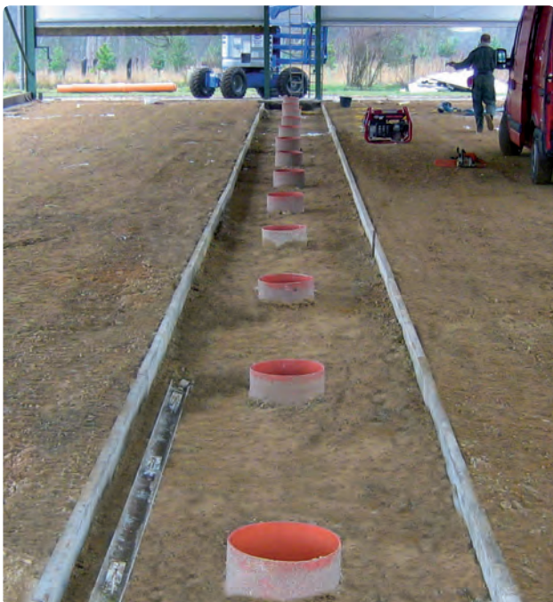
Vorbereitung zur Betonierung
