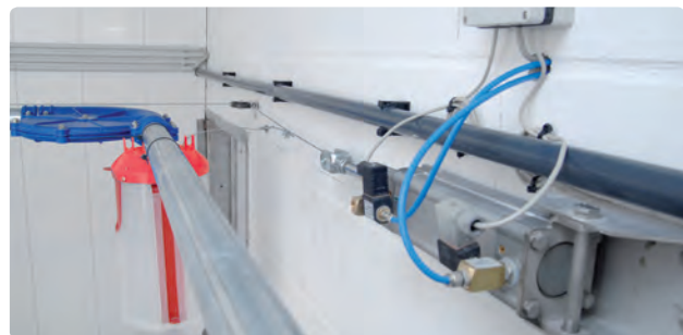
Automatischer Auslösemechanismus für den Volumendosierer
