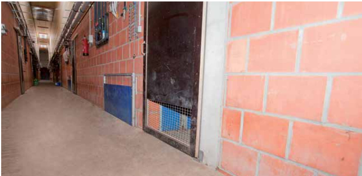
Ventilação pela porta do corredor
