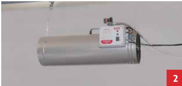
1 Tubo frisado 2 Ventilador movido a gás
