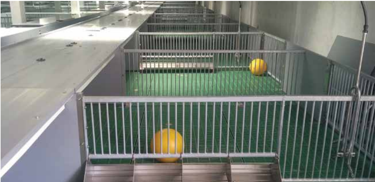
Baia de creche para ventilação de túnel
