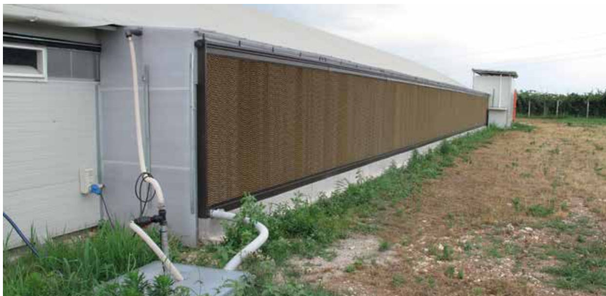
Sistem de climatizare cu PAD
