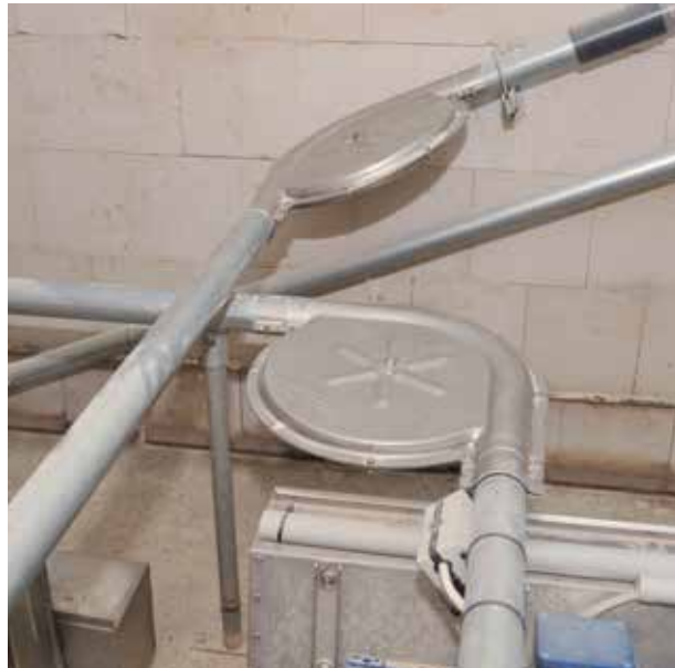
Deflector de colț realizat din oțel inoxidabil
