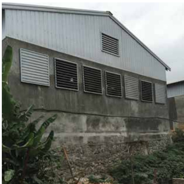
Ventilație tunel combinat
