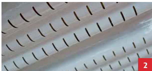
1 Plafon perforat 2 Plafon trapezoidal
