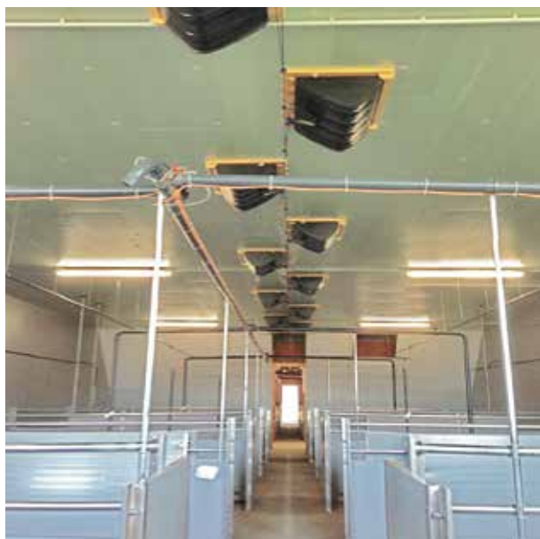
Element de ventilație plafon
