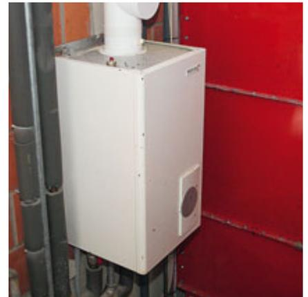
Eine Gastherme bringt bei Wilkens täglich 3800 l Wasser auf eine Temperatur von 45 °C – was ihn 8 Euro Gas kostet. Durch das Aufstellen von Pufferspeichern genügt eine niedrige Anschlussleistung für die Therme.
