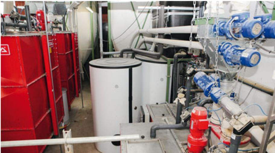
Großer Platzbedarf: Sofern wie hier die beiden Fermenter und die Pufferspeicher für das warme Wasser in der Futterküche aufgestellt werden sollen, besteht ein entsprechender Platzbedarf.
