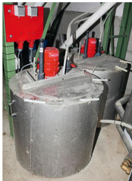
*Die Vermehrung der Bakterien erfolgt bei Wilkens noch in zwei wärmeisolierten Behältern. Inzwischen können die Bakterien auch direkt in den Fermenter gekippt werden.*
