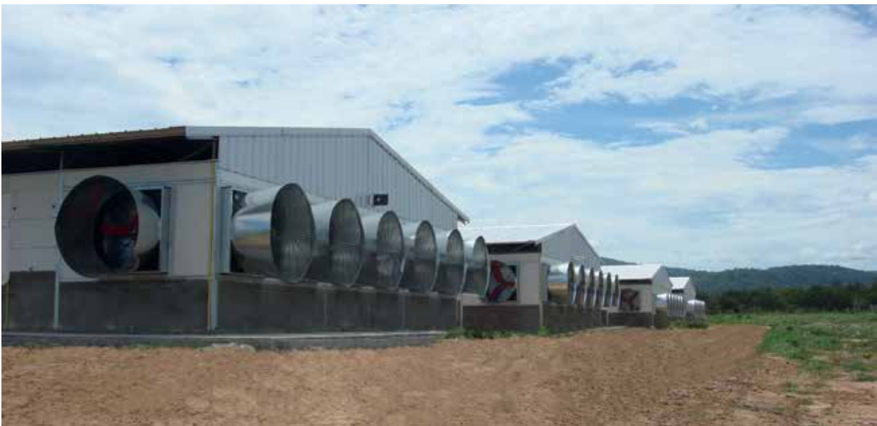
ระบบระบายอากาศแบบอุโมงค์ ที่มีพัดลมทรงกรวย
