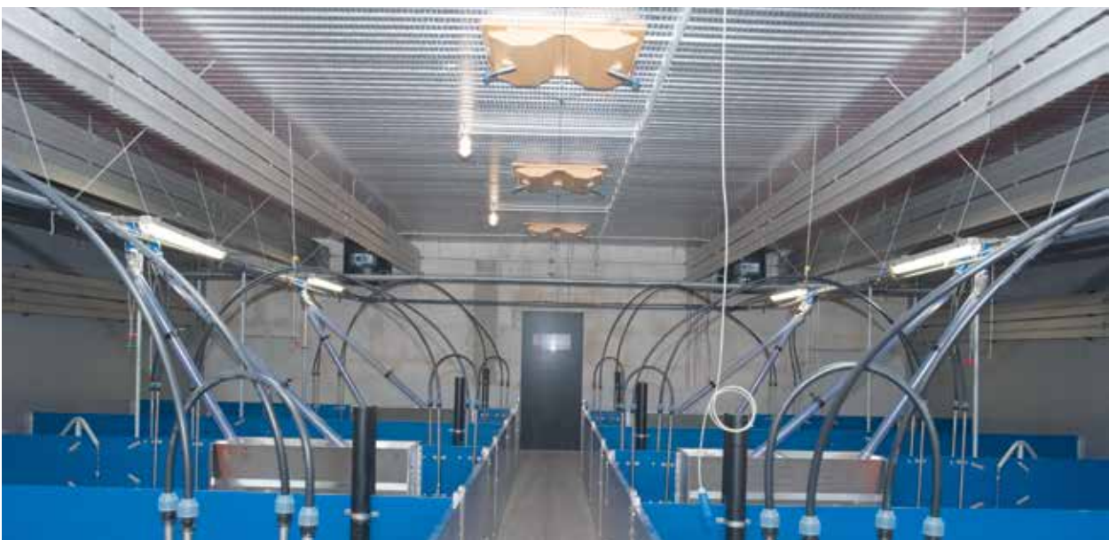
การป้อนอากาศเข้าแบบกระจาย combi
