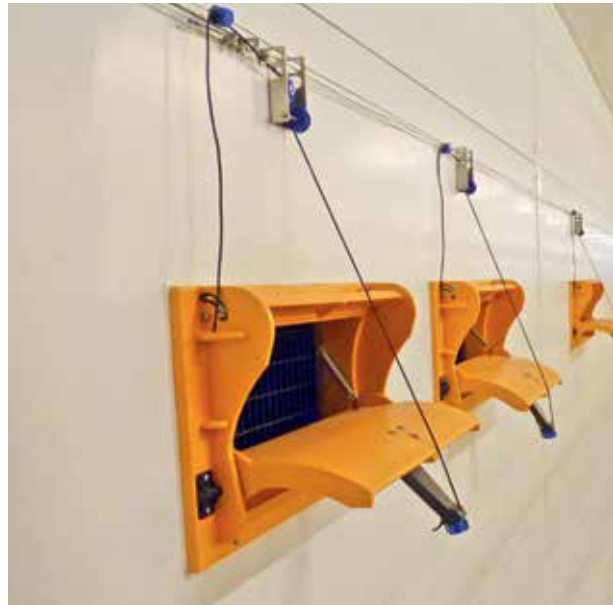
วาล์วจ่ายอากาศอากาศที่ผนัง
