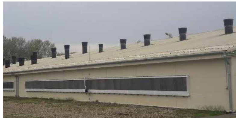
...und durch Cooling Pads
