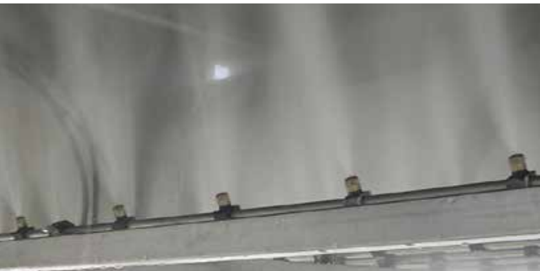
Die adiabate Kühlung durch Hockdruck Sprühkühlung
