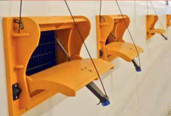
Die Zuluft (hier Wandventile)
