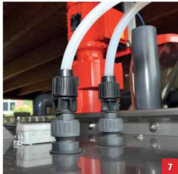
混合罐上有酸/碱清洗连接。
