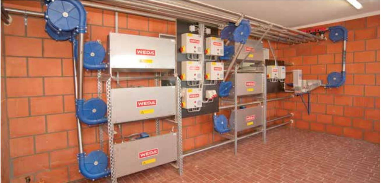
6 条输送管线的干料饲喂系统控制中心
